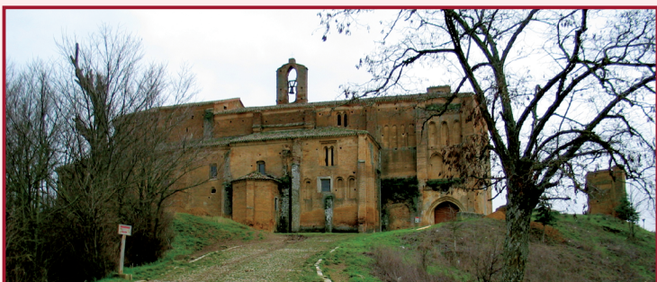
Santuario de La Peregrina. Estado previo a la intervención.
